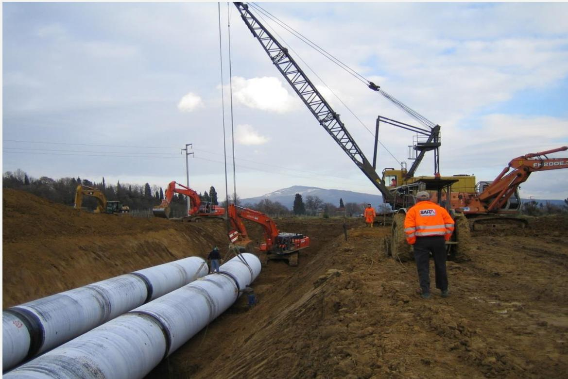
Per le reti nuove di adduzione l'installazione di un sistema di p.c. diventa più facile sia per la sua progettazione sia per la sua realizzazione, perché la rete è fatta interamente in acciaio con un rivestimento ad alta resistenza, sono presenti i giunti dielettrici e non sono presenti contatti elettrici con strutture terze.
